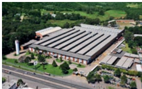
Sede Administrativa e Montadora de Tratores, Motores e Produtora de Componentes Caxias do Sul - RS - Brasil
